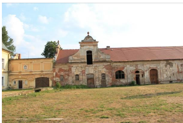
Ryc. 40. Zabudowa gospodarcza – łącznik z pałacem (B1e.) oraz fragment stajni (B2) – pld. skrzydło folwarku
