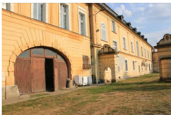
Ryc. 42. Pałac – zachodnia (tylna) elewacja
