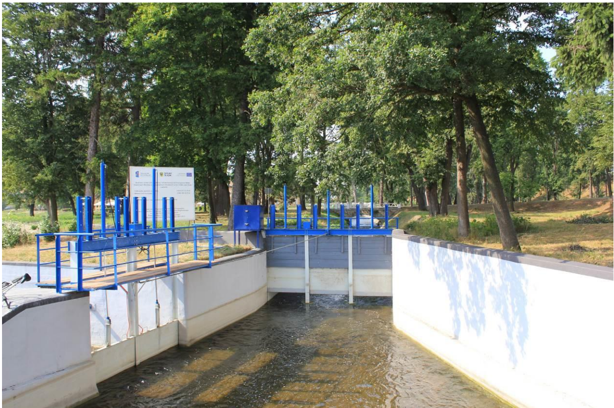
Ryc. 61. Budowla hydrotechniczna (W5.) – jaz w korycie rz. Białej Łądeckiej z zastawką spiętrzającą wodę i zastawka u wlotu kanału wodnego.
