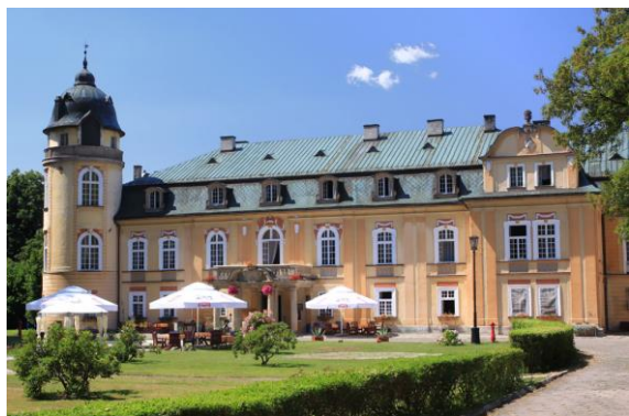
Ryc. 38. Pałac w Żelaźnie – widok głównej elewacji (źródło: www.polskieszlaki.pl/palac-w-zelaznie.htm )
