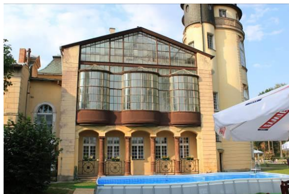
Ryc. 39. Pałac w Żelaźnie – palniarnia (B1b.) – pld. elewacja
